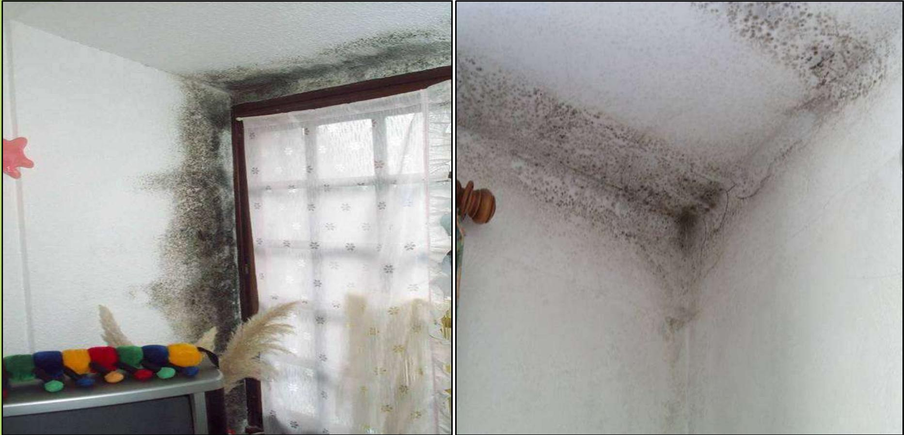
***Pont thermique. Isolation et ventilation déficientes***
